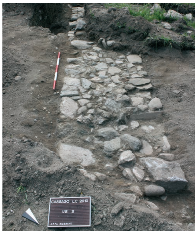
235 - Cassago Brianza, ex Parco Villa Visconti di Modrone. Rasatura di muro perimetrale.
