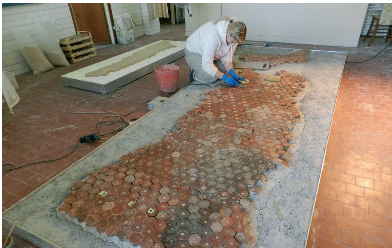
344 - Broni, via Cavour - via Solferino. Pavimento di età romana durante le operazioni di restauro.
