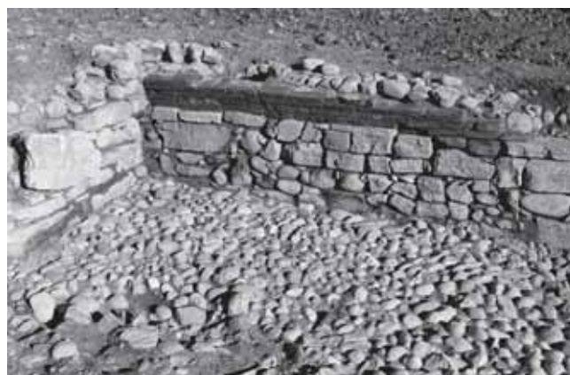
7 - Bolgare, via S. Antonio 1. Attacco della volta di copertura in mattoni.
