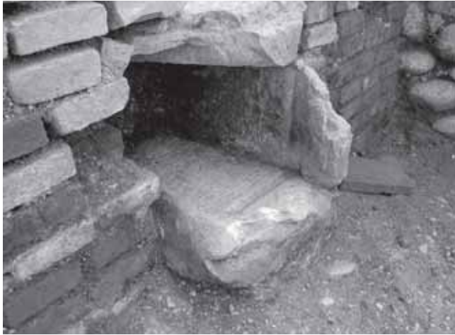
8 - Bolgare, via S. Antonio 1. Imboccatura del canale di deflusso.
