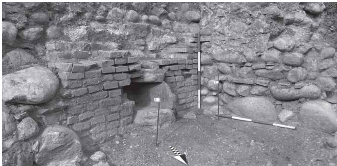
6 - Bolgare, via S. Antonio 1. Estremità sud della vasca.
