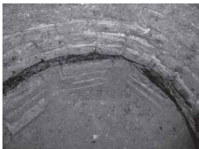
20 - Fontanella, chiesa di S. Cassiano Martire. Parte inferiore del pozzo con travi lignee poggianti su pilastrini in laterizi.
