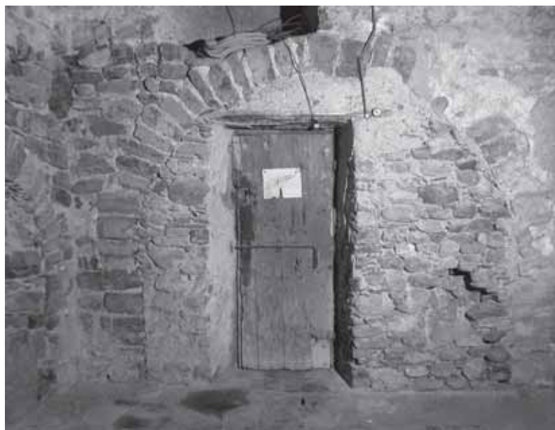
56 - Cividate Camuno, Pieve di S. Maria. Arcone d'accesso alla cappella del campanile.
