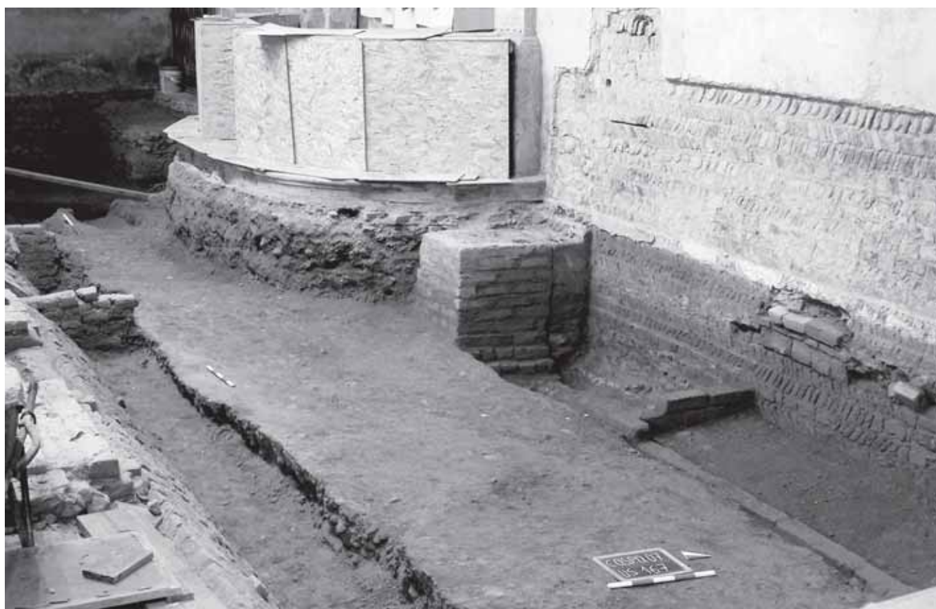
188 - Cornaredo, chiesa vecchia di S. Pietro all'Olmo. Le lesene romaniche dell'aula.
