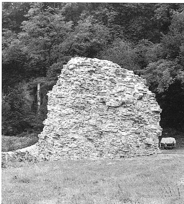
194 - Almenno S. Salvatore, ponte "della Regina" Il pilone dopo l'intervento di restauro.
