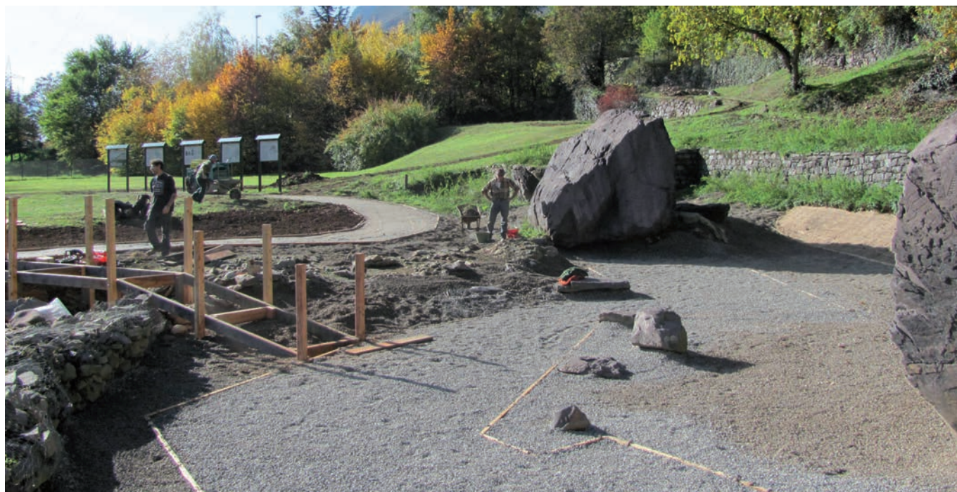
392 - Parco Archeologico Nazionale dei Massi di Cemmo. La passerella in costruzione, ottobre-novembre 2010.
