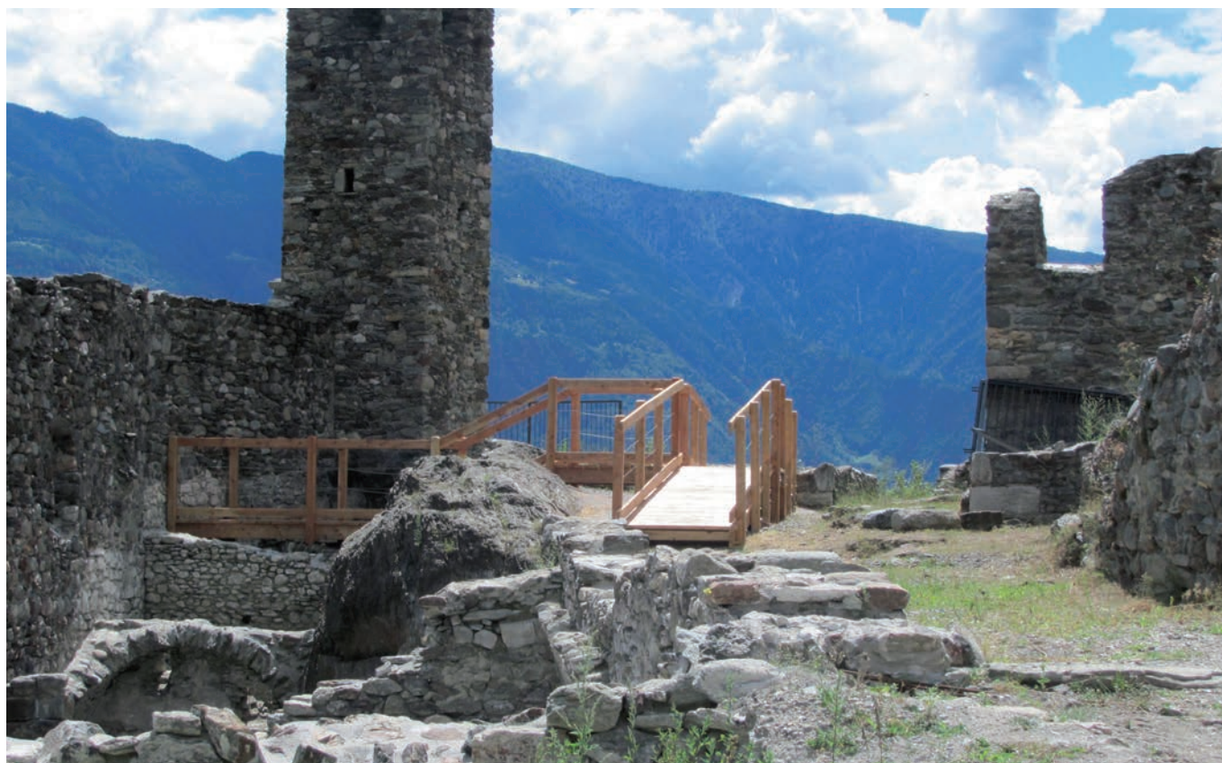
409 - Grosio, Parco incisioni rupestri. La nuova passerella al Castello Vecchio.
