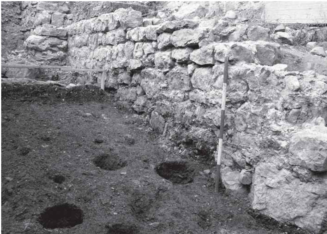
104 - Civate, chiesa di S. Pietro al Monte. Struttura rinvenuta e fori per impalcatura.
