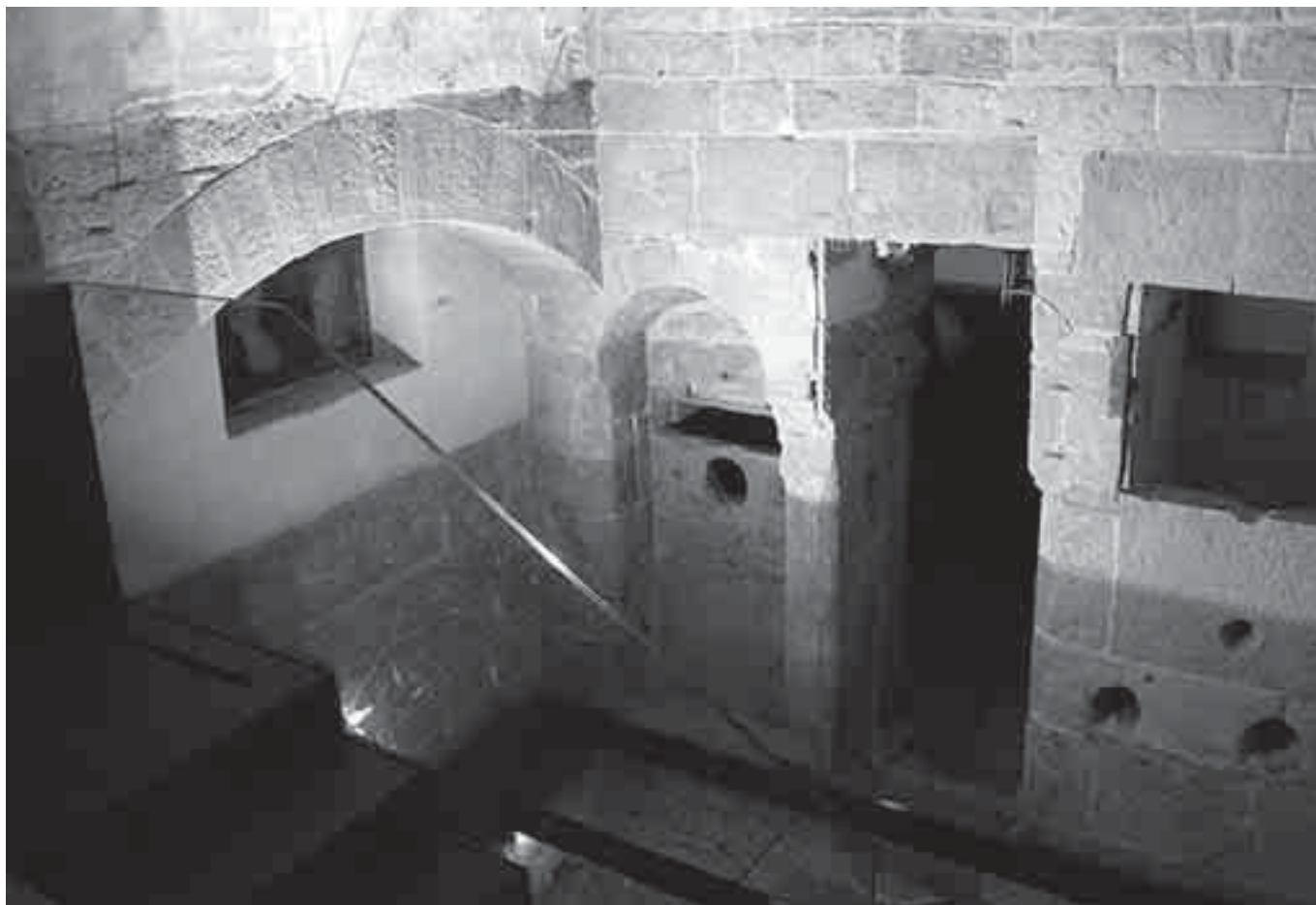
6 - Bergamo, via Colleoni 13. Vista dell'interno.
