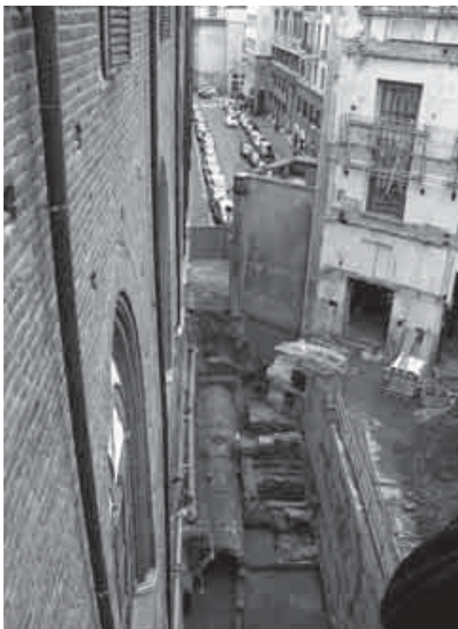
159 - Milano Palazzo dell'Arengario. Veduta generale dello scavo dall'alto.
