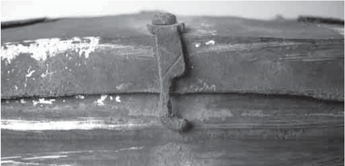
311 - Sirmione, chiesa di S. Pietro in Mavinas. Il sistema di chiusura anteriore e i resti della saldatura.
