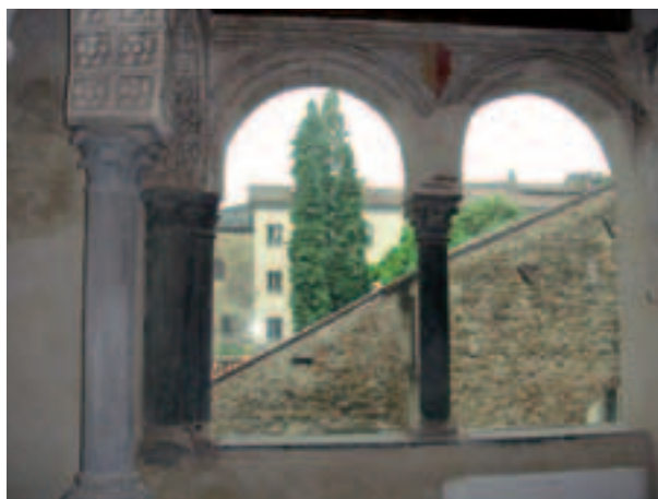
Fig.1: Bifora nel chiostro al piano primo riscoperta durante i lavori di restauro.
