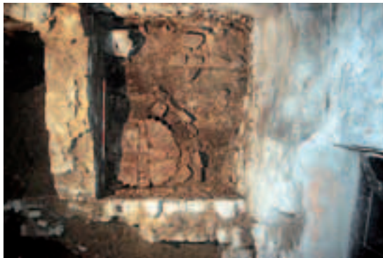
Fig.6: Struttura US 480-482 angolo nord-est (ante restauro).
