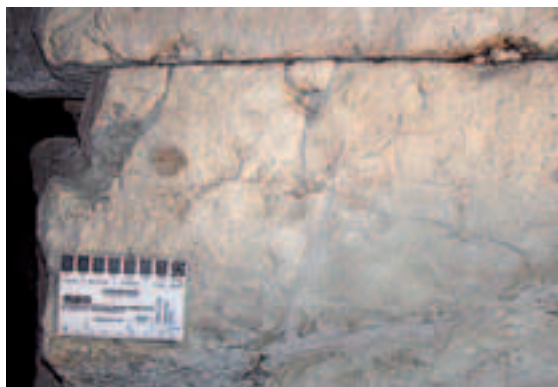
Fig.4: Tipiche superfici di frattura concoide ed un piccolo nodulo di selce in un manufatto di Maiolica.
