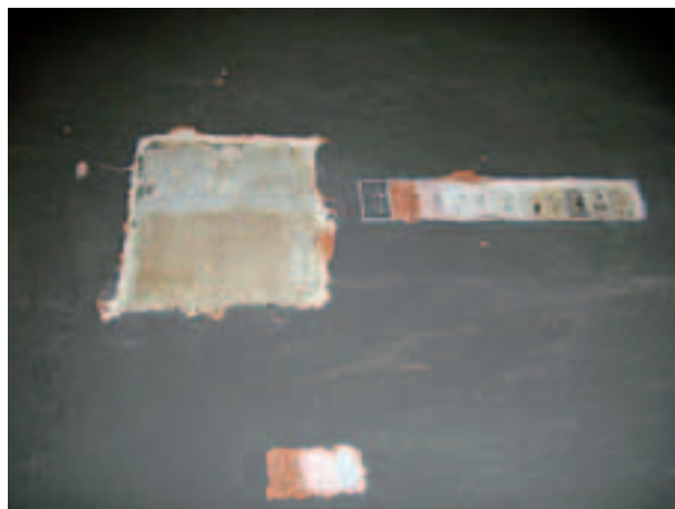
Fig.7: Saggio stratigrafico degli intonaci: rilevate undici stratificazioni.
