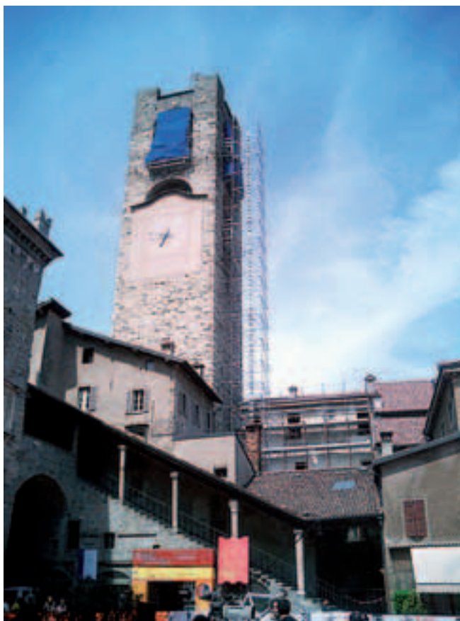
Fig.1: I restauri della torre: il ponteggio esterno
