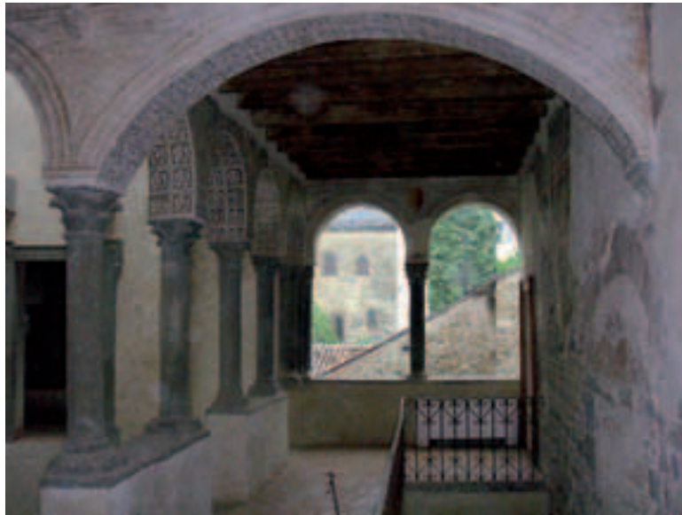
Fig.4: bifora nel chiostro al piano primo riscoperta durante i lavori di restauro.
