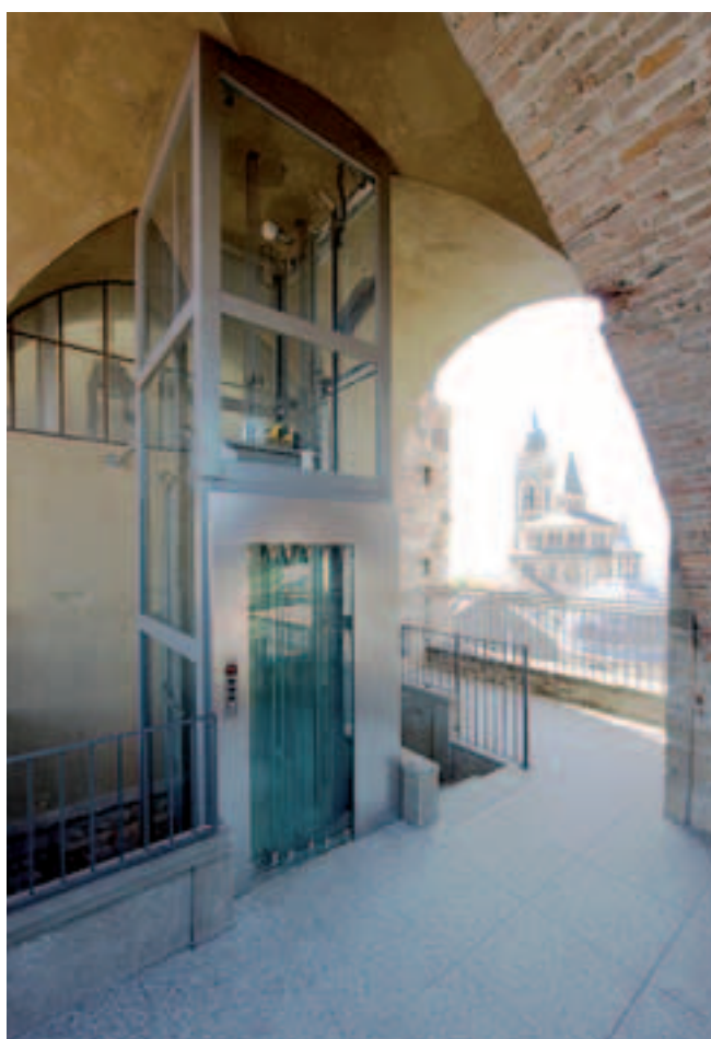
Fig.4: Ascensore: fermata al livello della Sala dei Giuristi.
