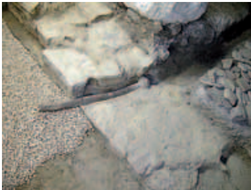
Fig.5: La fistula US 593 dopo i trattamenti.
