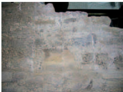
Fig.2: Prove di pulitura dei paramenti murari.
