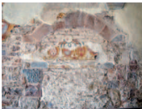
Fig. 7.2 - 7.3: Loggiato, piano primo; prospetto ovest – dettaglio aperture tamponate e sequenze intonaci dipinti.
