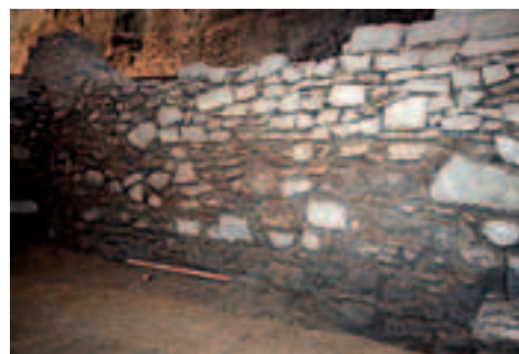
Fig.9: Perimetrale sud del complesso forense.
