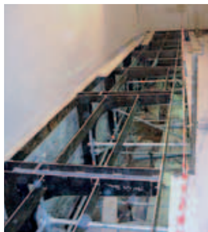
Fig.3: Struttura della passerella.
