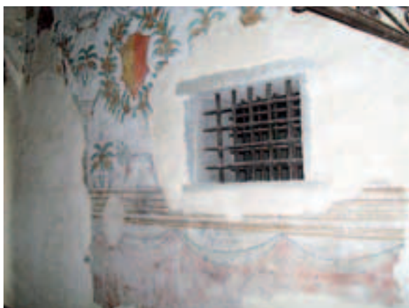
Fig. 7.6: Loggiato, piano primo; stanza 48 – dettaglio intonaci dipinti parete est.
