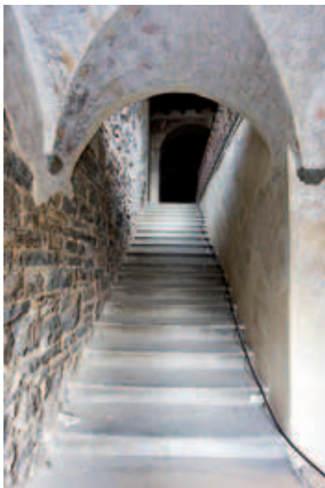
Fig.5: Scala di ingresso dal cortile di Piazza Duomo.
