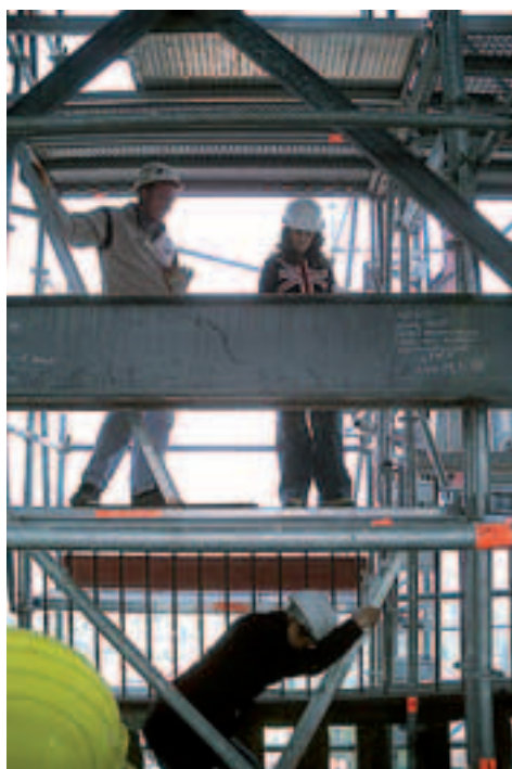
Fig.2: I restauri della torre: il ponteggio nella seconda loggia.
