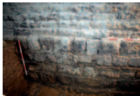
Fig.30: Riseghe di fondazione della Torre.
