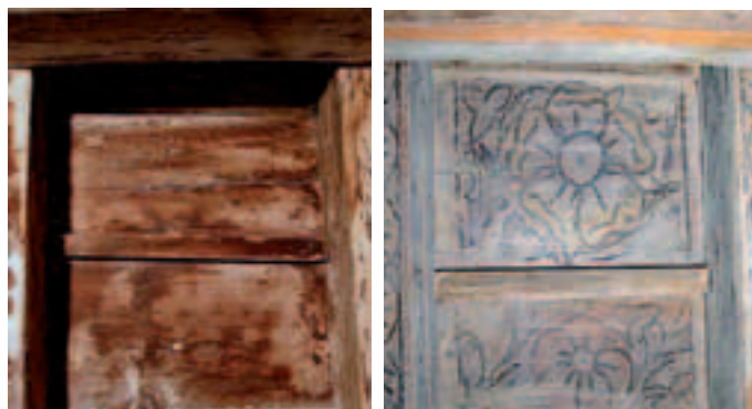
Fig. 8.12 - 8.13: Piano primo, vano 37; particolare soffitto ligneo prima e dopo il restauro.
