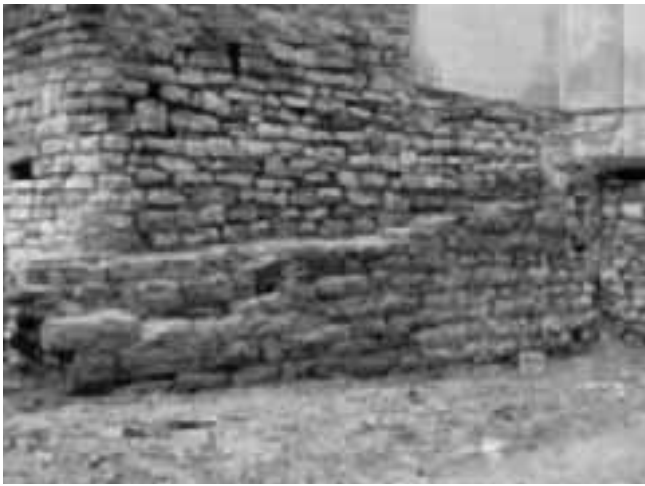
8 - Bergamo, via Tre armi. Struttura muraria.
