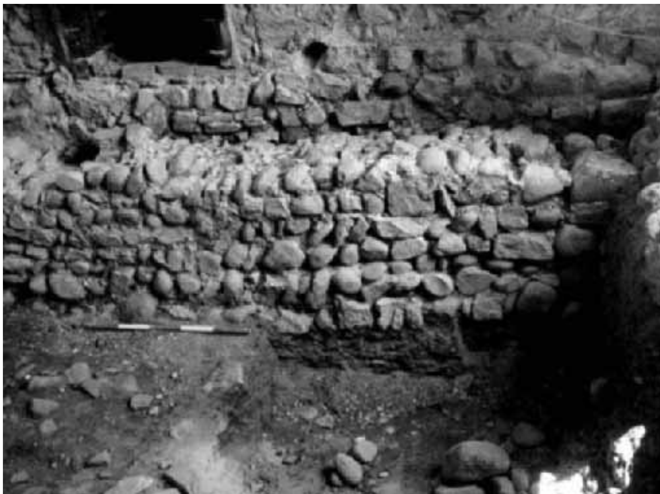
24 - Telgate, Casa Parrocchiale. Prospetto del muro perimetrale di età romana.
