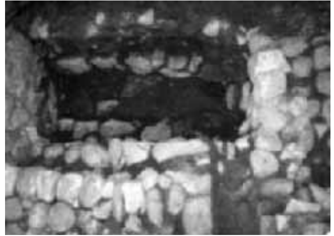
26 - Telgate, Casa Parrocchiale. Strutture murarie e tomba nel vano scale.
