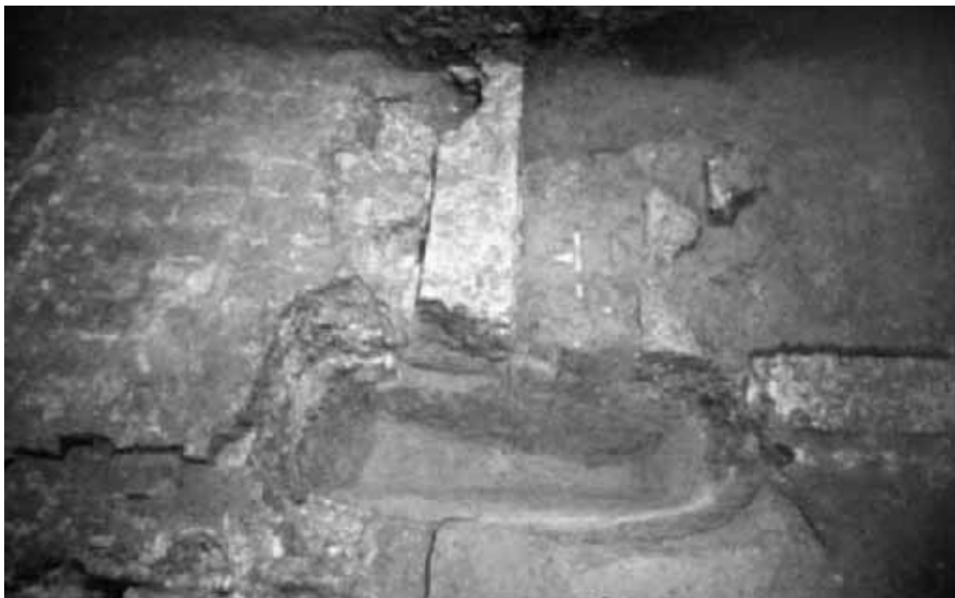
123 - Pavia, ex convento di S. Maiolo. La vasca della fase III.
