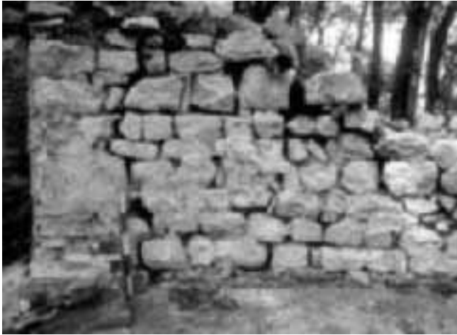
134 - Varese, chiesa di S. Francesco in Pertica. Paramento murario dell'abside.
