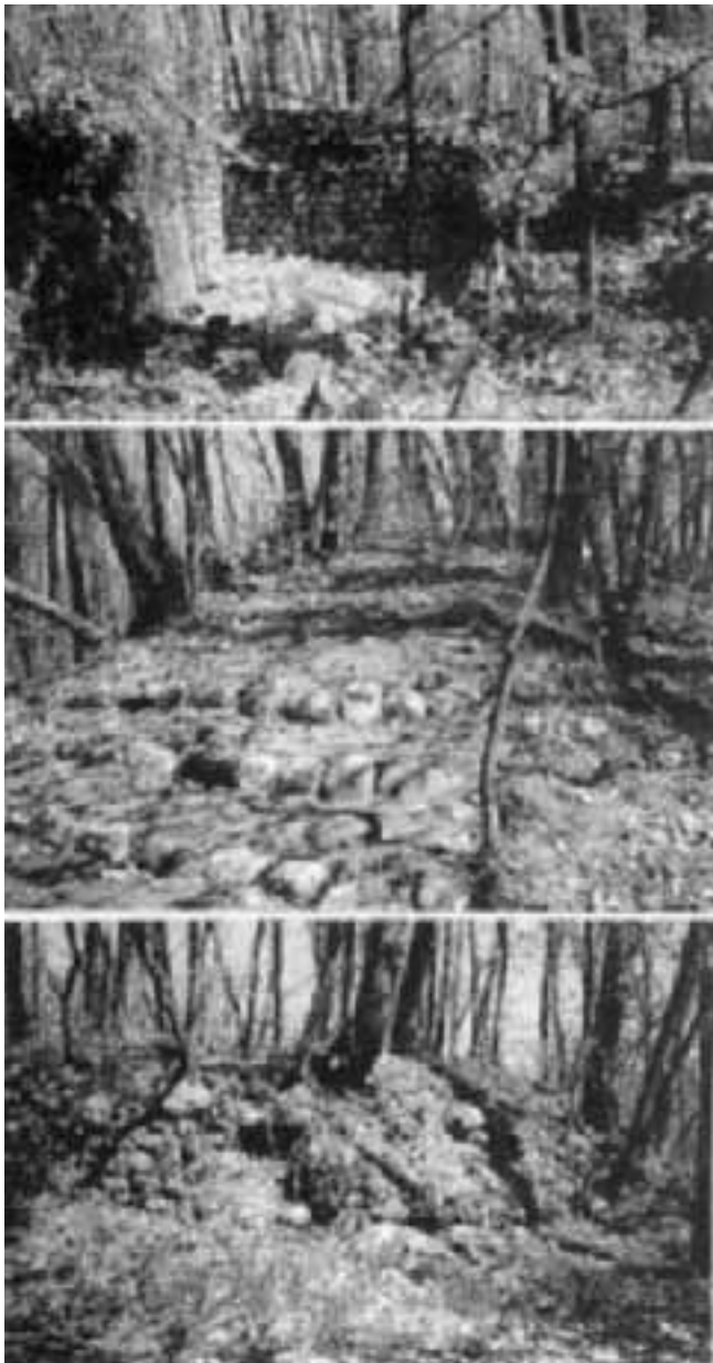
171 - Castelseprio, località Sgarlasc. Alcune strutture dopo sommaria pulizia.
