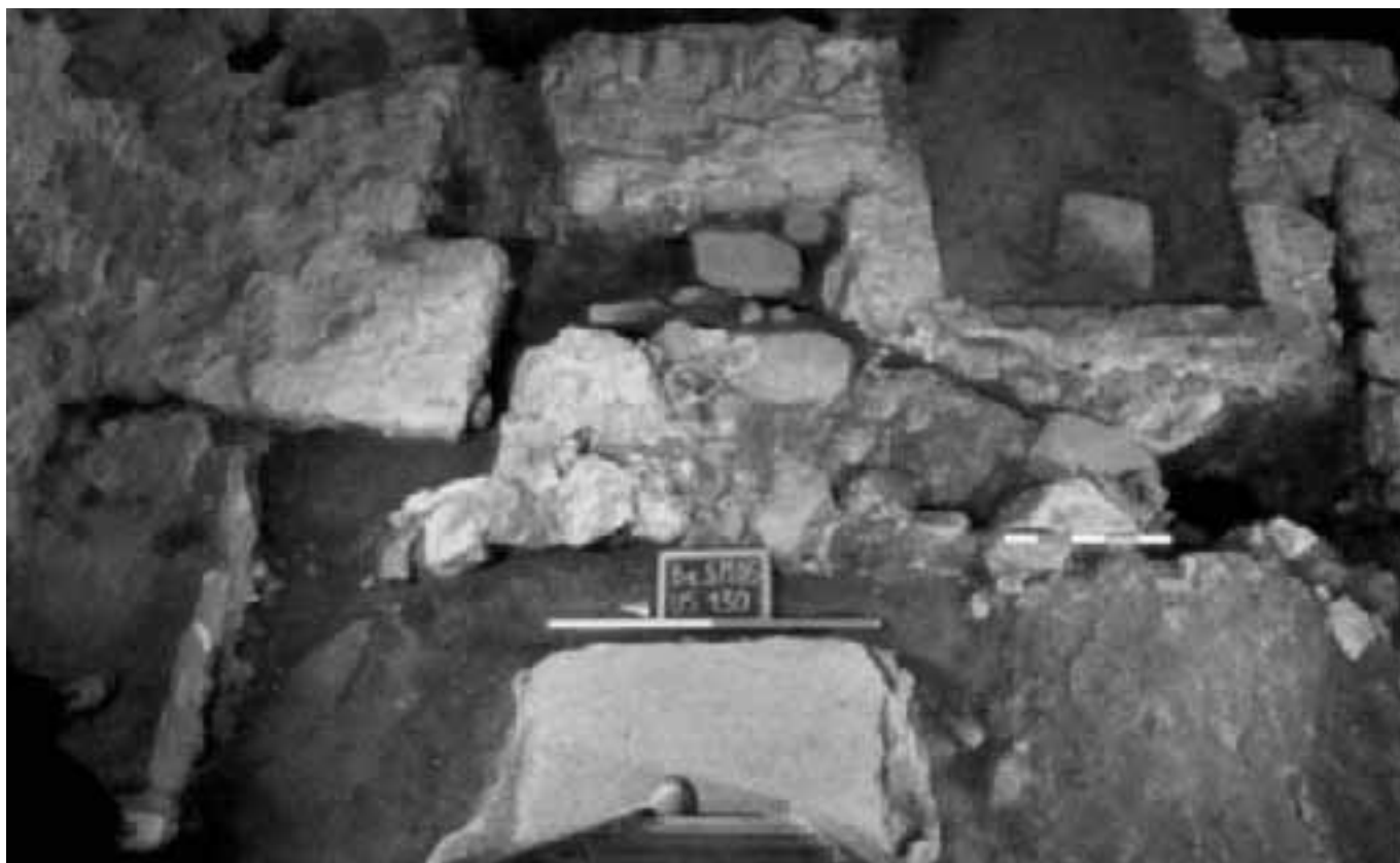
155 - Besnate, chiesa di S. Martino di Tour. Abside romanica.
