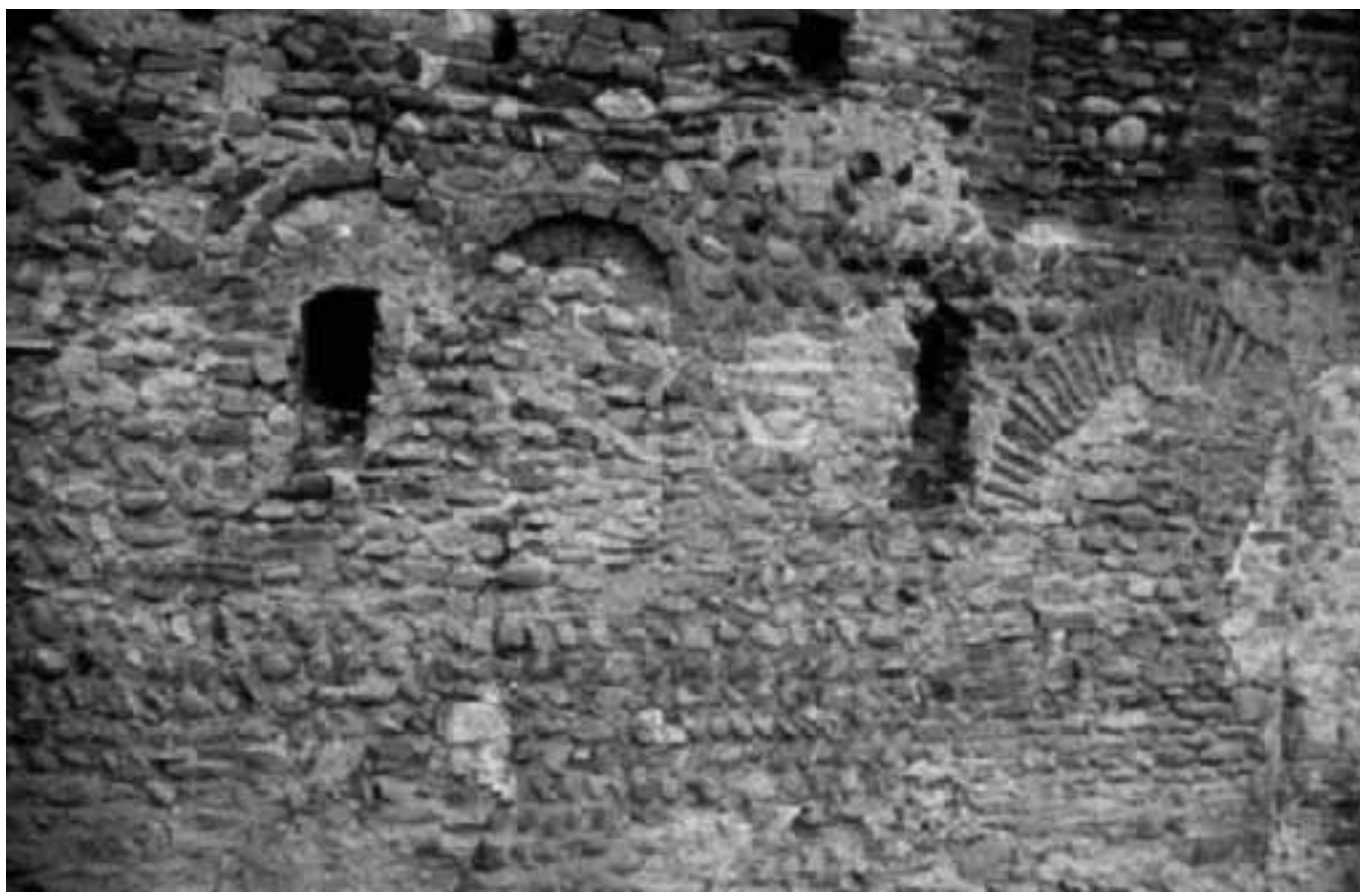
169 - Cairate, ex monastero di S. Maria Assunta. Fronte settentrionale del primo edificio a due piani del monastero, precedente la costruzione del chiostro. Sulla tecnica muraria a "spina di pesce" sono evidenti diverse aperture del periodo romanico, poi tamponate.
