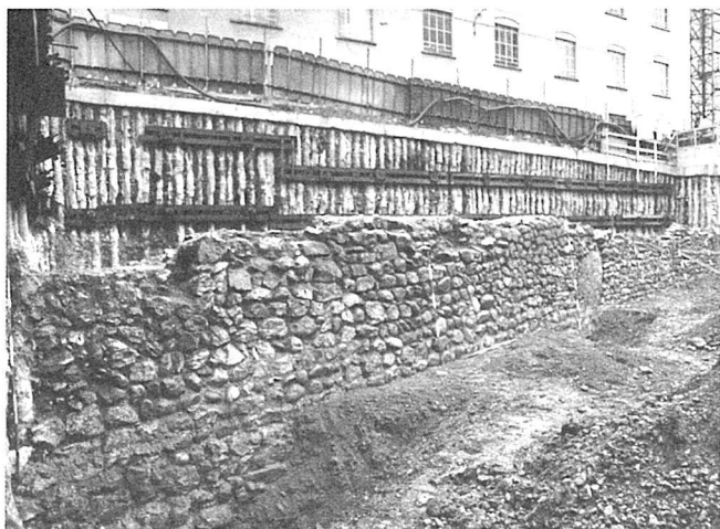
110 - Lecco, cinta muraria. Veduta delle mura in corso di scavo.
